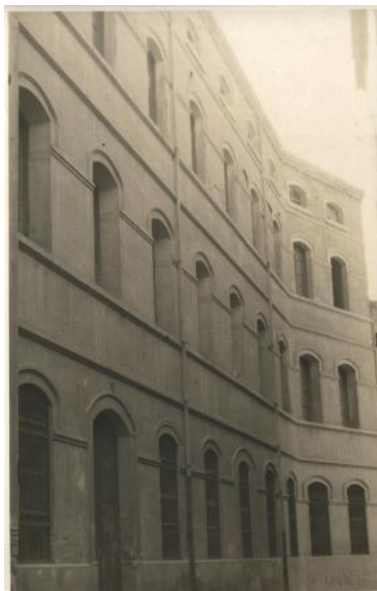
Part darrera de la casa dels claretians al carrer la Palma.
